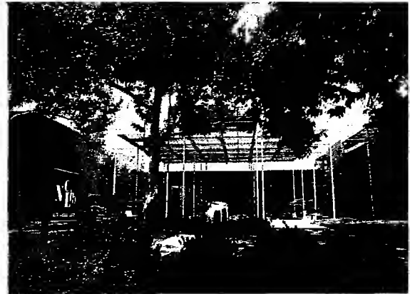
صورة (٣٦٥): منظر خارجي لمكتبة جامعية لاحظ وضع سقف خشبي طويل فوق المدخل لمنع تغلغل أشعة الشمس إلى منطقة المدخل
